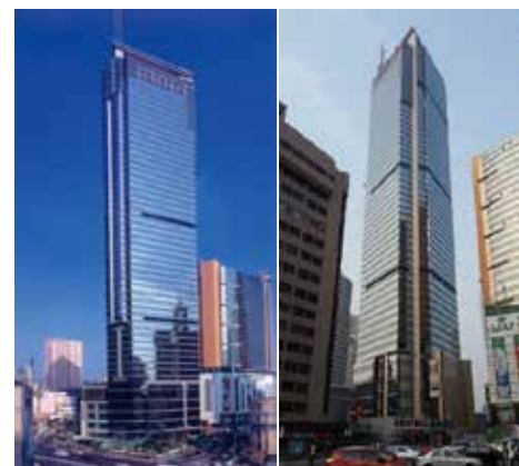
Dalian Tian An International Tower 大連天安國際大廈
